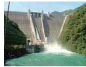
宮ヶ瀬ダムの放水風景
